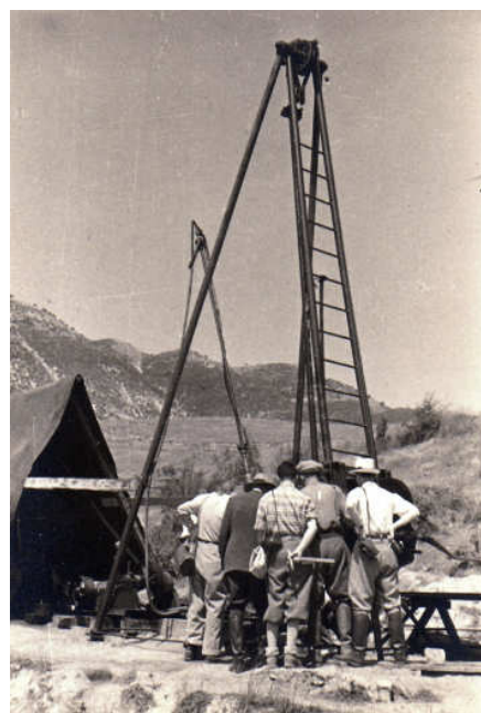
8. Foto del cantiere di Devoli
